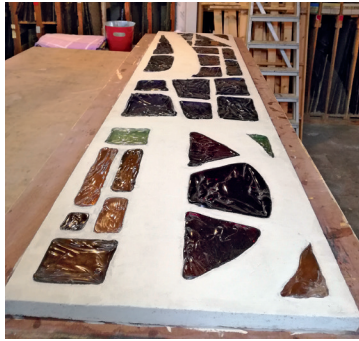
Fig. 29 – Gare de Liège-Guillemins, vitrail en dalles de verre à joints de béton, élément en restauration aux Ateliers d'Art Pirotte à Beaufays.
