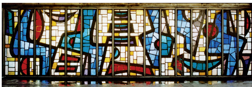
Fig. 28 – Gare de Liège-Guillemins, architectes Groupe Egau, vitrail en dalles de verre à joints de béton, composition en seize panneaux de 2,55 x 9,60 m. © SNCB – Denis Moinil.
