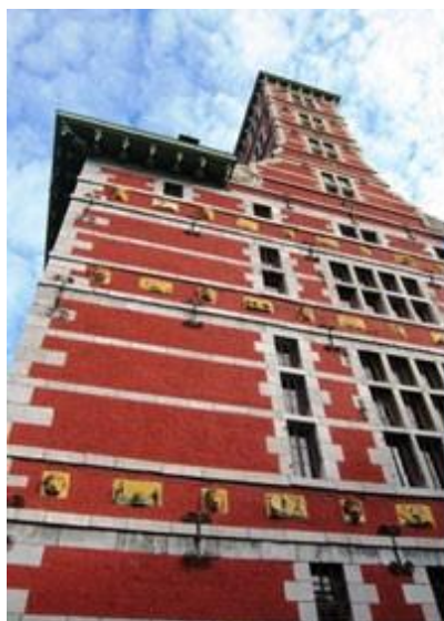
◀ Palais Curtius, façade-pignon, à l'ouest.
