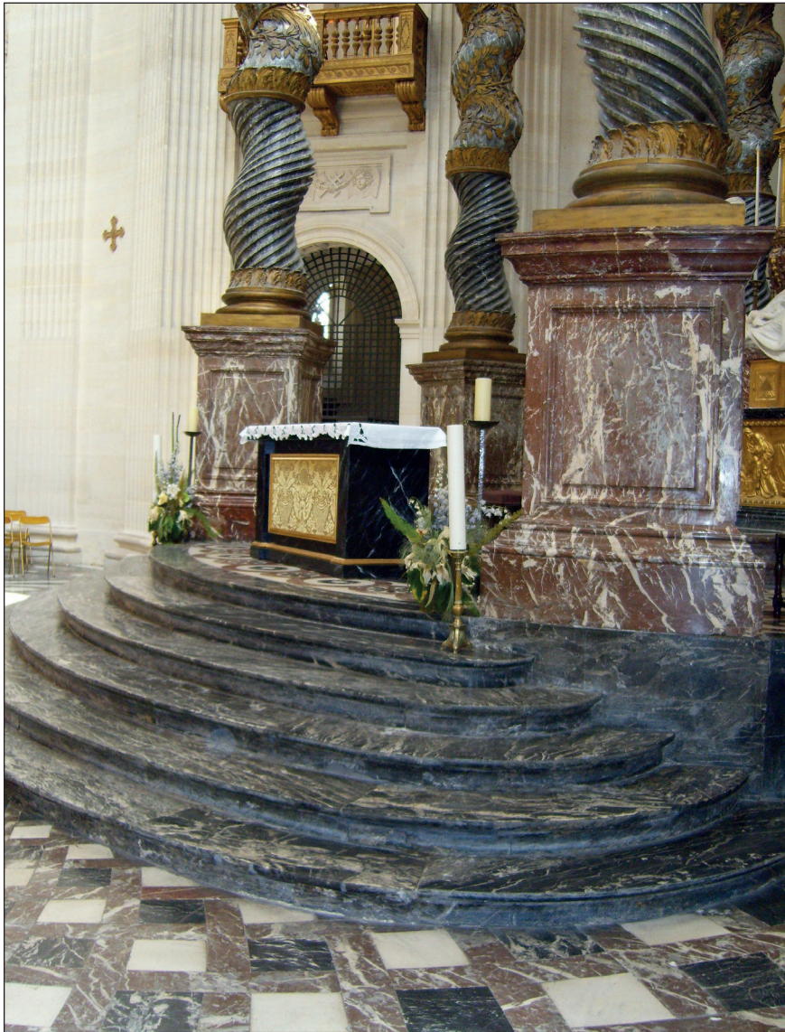
Fig. 5 (a-b) – Paris, église du Val-de-Grâce, baldachin monumental de Philippe de Buyster. Sous les six colossales colonnes torses de marbre veiné de Barbençon, d'un grand raffinement dans leur finition et leur décor de bronze doré, les socles monolithiques en marbre jaspé de Gochenée, livrés par Philippe-Georges Tabaguet en 1664. © Francis Tourneur (Pierres et Marbres de Wallonie).
