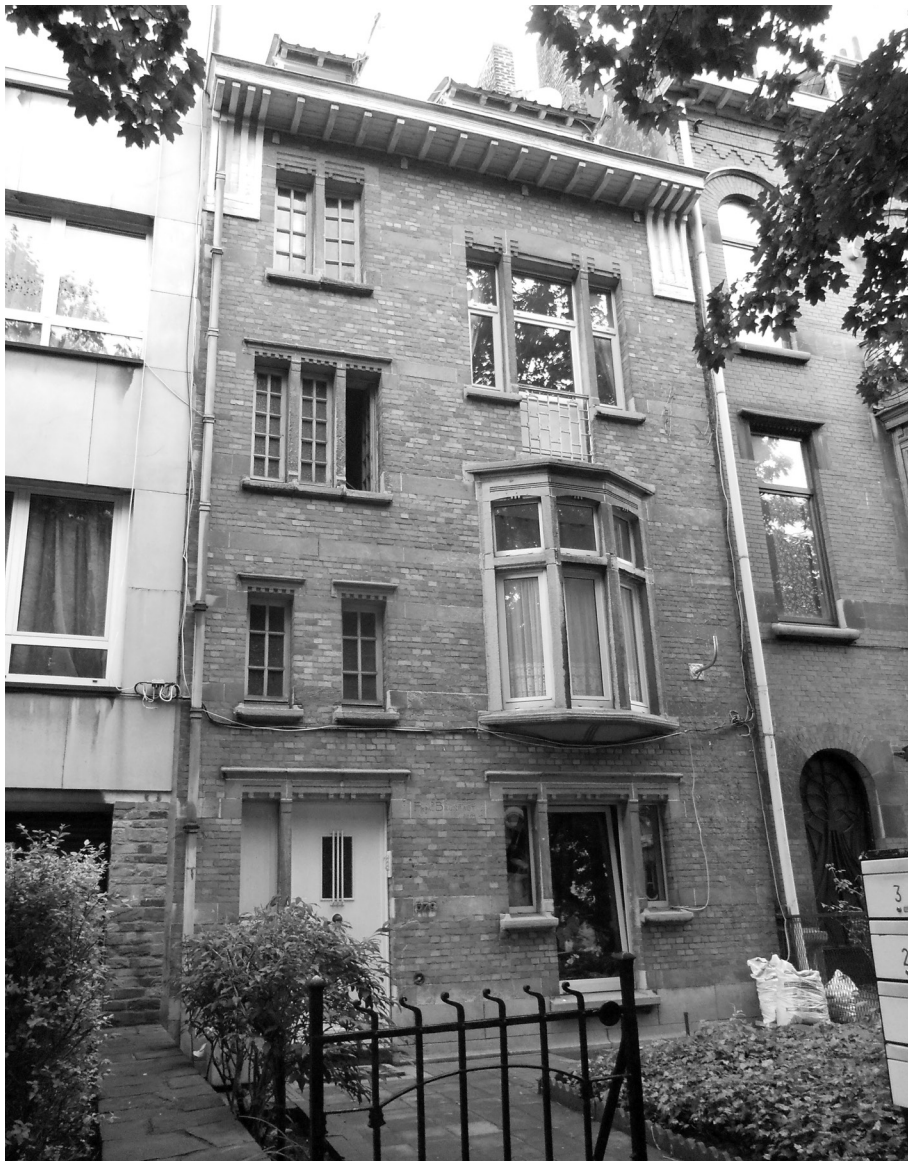
Laeken, maison Fernand Brunfaut, bd de Smet de Naeyer Première maison primée au premier concours de façades pour les maisons construites sur terrains communaux (1911-1913). Architecte : Fernand Brunfaut.
