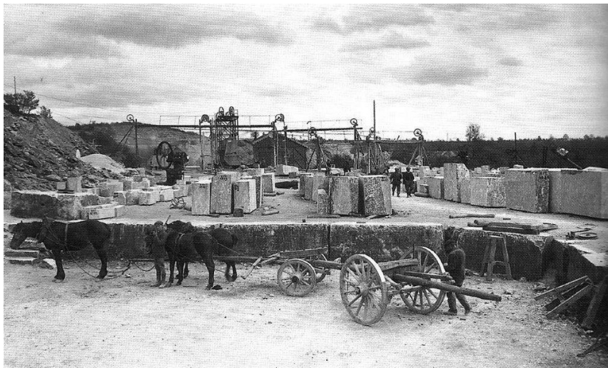
Fig. 1 « Chantier de la carrière de Hautmont à Vodelée au début du XX e siècle, montrant à l'arrière-plan le débitage au fil hélicoïdal des blocs, à l'avant-plan un attelage attendant sa charge. Archives de la Société de Merbes-Sprimont », Pouvoirs de marbre , Dossier de la Commission royale des Monuments, Sites et Fouilles, Pierres et marbres de Wallonie, Liège, 2004, p 60.
