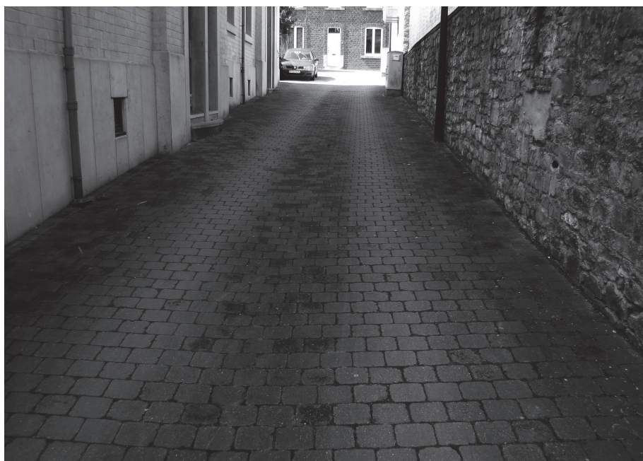
Fig. 2 : Bouvignes, ruelle issue de la rénovation urbaine.
