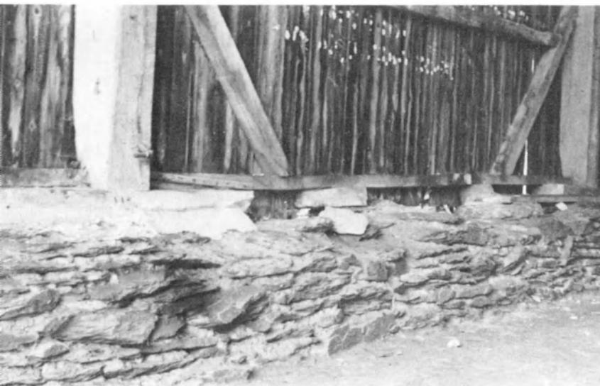
Fig. 7. Soubassement maçonné continu du séchoir.
