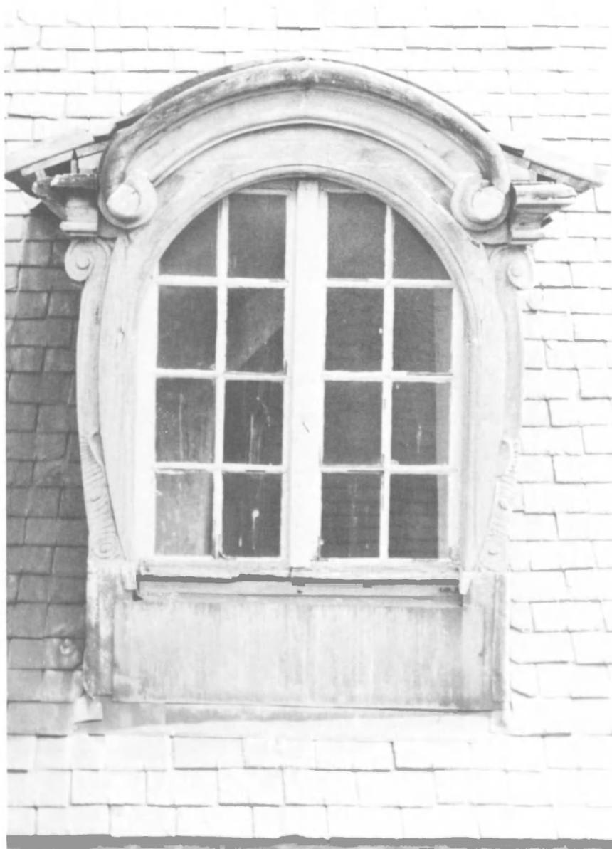
Fig. 60. Lucarne à fronton courbe de la façade ouest (1966).
