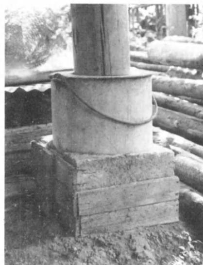
Fig. 8. Socle en béton et son coffrage.
