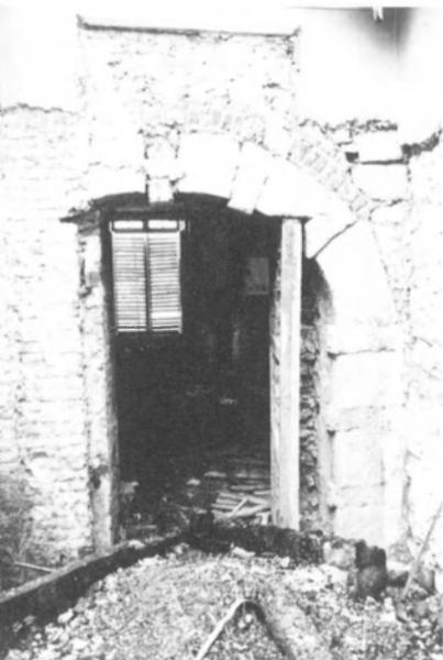
Fig. 47. Porte en plein cintre condamnée dans l'angle N.-O. du hall d'entrée (1966). cliché M. Gilis.
