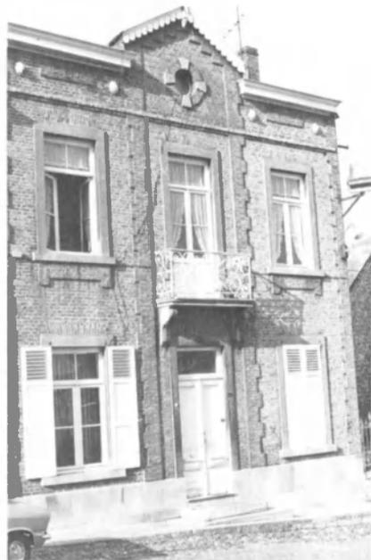
11-13. Il s'agissait à l'origine d'une maison néo-classique à double corps en moellons sur soubassement en pierres de taille, qui se caractérisait pas trois travées d'ouvertures également réparties, à linteau droit et seuil saillant aux deux niveaux inférieurs et en demi-lune au demi-étage sous bâtière à demi-croupes.
