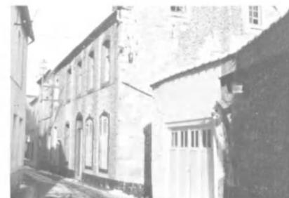
**16.** Dans le mur en moellons à l'angle de la rue Barbier, un portail gothique chanfreiné en pierre appareillée de la 2<sup>e</sup> moitié du XVI<sup>e</sup> siècle, a été gravement mutilé par le percement en 1952 d'une porte de garage. En subsiste le départ de l'arcade formé de claveaux et doublée d'une archivolte moulurée en saillie, s'amortissant sur un culot simple. Au-dessus, se voit un fragment de mur en pierre de taille.
