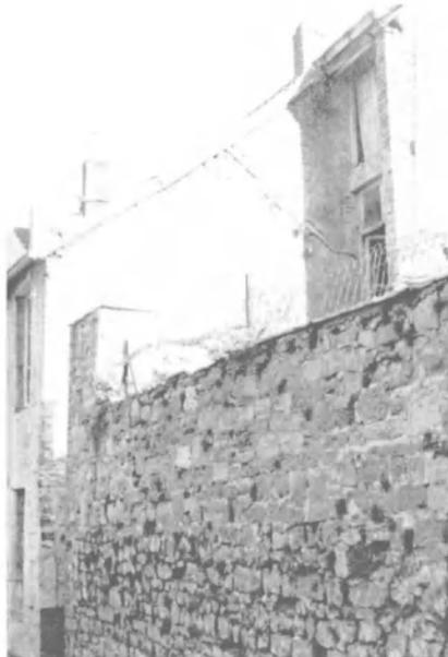
rue et la rue Guiot, vers la rue Fétis, le volume du 6, prolongement des 2-4, a conservé au rez-de-chaussée en moellons du XVIII<sup>e</sup> siècle un chaînage d'angle à droite, une porte chaînée transformée en fenêtre et une porte à encadrement de briques plus récente. L'étage contemporain de celle-ci est également en briques.
