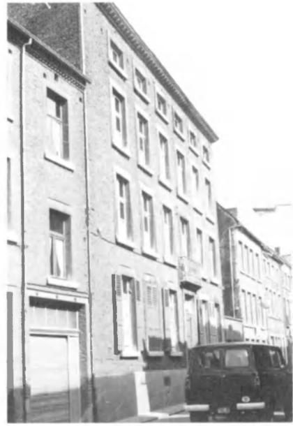
porte sous baie d'imposte décorée de flèches croisées et le balcon en fonte, caractéristiques de ce style. Des pierres d'attente à droite, montrent l'intention d'agrandir encore le volume.
