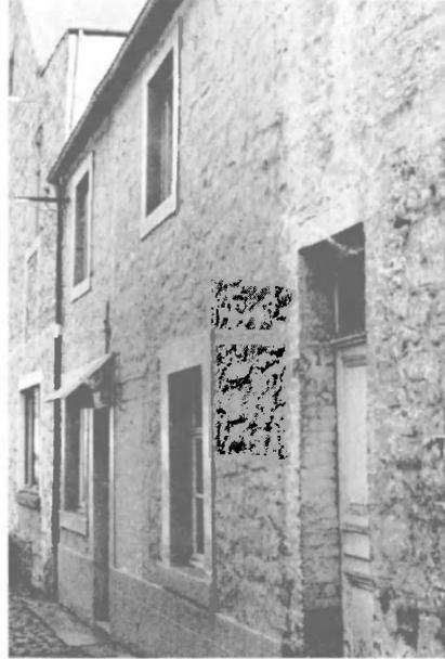
**7.** Séparée depuis 1847 du 20 rue Richier et du 5 rue Genard, la maison a été reconstruite depuis, en briques et moellons de calcaire de remploi au rez-de-chaussée où les ouvertures à linteau métallique sont plus récentes.
