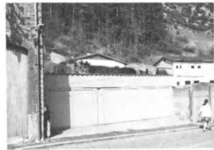
25. Ancien bâtiment rural, le volume en moellons calcaires et briques a été construit en 1904 par J. Pâquet. Il comportait une écurie surmontée d'un fenil et une grange sous une bâtière d'ardoises. Les ouvertures surbaissées sont encadrées de briques. Il a été transformé en 1978 en habitation et des ouvertures nouvelles également à encadrement de briques y ont été percées.
