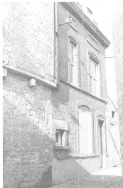
4. Il s'agit d'un ensemble de dépendances du 7 rue Barbier : à gauche, un appentis bas, construit en moellons de calcaire en 1927 comme remise du 2 et à droite, un garage plus récent en briques également sous appentis.
