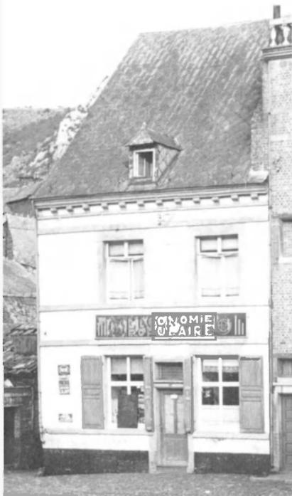
Fig. 92. La façade du 8 place du Bailliage en 1943, document de réel intérêt demandant une restauration appropriée plutôt que la construction d'un pastiche dénué de valeur. A remarquer sous la corniche, les ancres incomplètes.
