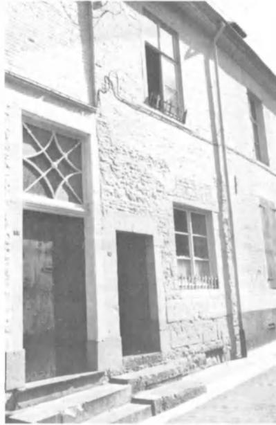
54. Datée par ancrés de 1735, la maison de style traditionnel en briques et pierre bleue chaulées sur soubassement en pierres de taille, se distribue en un double corps de trois travées d'ouvertures espacées à linteau droit sur montants à queues de pierre. L'intérieur conserve outre un escalier remanié, des plafonds moulurés, des cheminées et un salon orné de boiseries Régence. Une pièce de bois réemployée pour consolider la charpente est millésimée de 1584.
