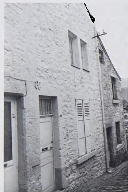
montants à queues de pierre, chanfrein et congés, jumelée à celle du 7 et surhaussée lors de la division qui entraîna aussi le percement des autres ouvertures constituées partiellement de matériaux de remplissage. A l'arrière, au-delà d'une façade en arrondi presque aveugle et d'une courrette couverte, s'élève une dépendance également en moellons et sous appentis.
