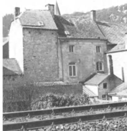
**71.** Remontant à la 2<sup>e</sup> moitié du XVIII<sup>e</sup> siècle comme le montent à l'arrière les deux niveaux inférieurs éclairés de baies à linteau courbe et clé passante, le volume s'est vu amputé à l'avant en 1850 lors de l'élargissement de la voirie et doté d'une façade néo-classique. Celle-ci est caractérisée comme celle du 69 par les ouvertures à linteau droit et seuil saillant ainsi que par le demi-étage.
