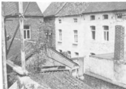
10. Construite vers 1905 par le tisserand Jh. Disy qui avait acheté le 6 en 1894, à l'emplacement de la poterie Delens démolie partiellement en 1885 et totalement en 1891, la maison est entièrement en briques sauf le soubassement couvert d'une imitation de céramique en ciment. Les trois travées de deux niveaux sont couvertes d'une toiture mansardée et ajourée de deux lucarnes à fronton triangulaire décoré.
