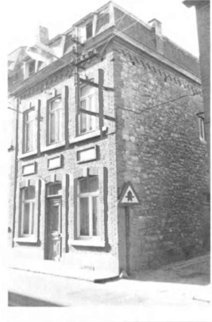
**64.** Derrière la façade récente en briques sur soubassement de moellons, se cache un immeuble du 2<sup>e</sup> quart du XVIII<sup>e</sup> siècle visible dans la ruelle qui aboutit place du Bailliage. De ce côté, le rez-de-chaussée en moellons calcaires, ajouré d'une fe-
