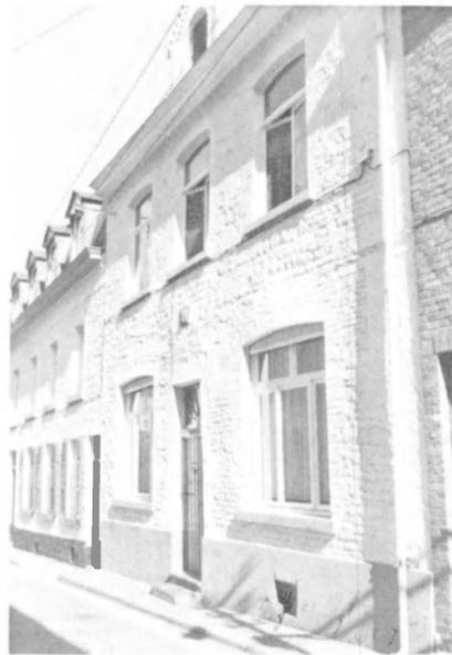
sur l'écu au-dessus de la porte dont subsistent d'origine le jambage droit et le départ de l'arc en plein cintre. Toutes les ouvertures comme la frise, la toiture et la lucarne axiale ont été refaites en briques au début de ce siècle, mais se devinent encore dans les moellons de la partie haute à droite du rez-de-chaussée, un jambage de petite baie contre le chaînage d'un angle et à l'étage, celui d'une fenêtre à croisée ou traverse.
