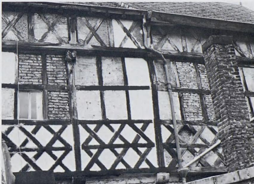
Fig. 82. Rue des Potiers 4-6, un remarquable pan de bois probablement antérieur à 1600, à encorbellements, où se lit clairement la suite des fenêtres à croisée assurant une lumière généreuse au bel étage. Témoin de la construction et de l'habitat à remettre en valeur.
