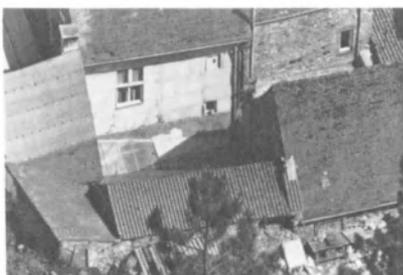
1. Le volume en moellons chaulés remonte au 2<sup>e</sup> quart du XVIII<sup>e</sup> siècle, mais n'a gardé qu'une baie d'origine à l'étage, à linteau droit sur montants à queues de pierre. Au rez-de-chaussée, la fenêtre a été transformée en porte ce siècle, puis reconvertie en fenêtre. La petite ouverture allongée à montants de briques entre des boullins sous la bâtière d'ardoises, est également postérieure.
