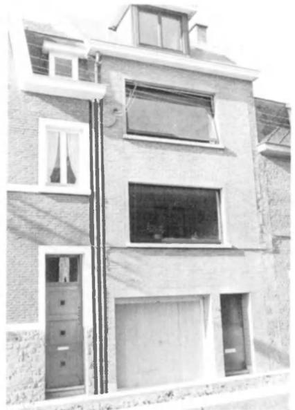
50. Sur soubassement en pierre de taille, la maison couverte d'un enduit imitant la brique, possède une façade refaite après la guerre. A droite, le pignon en moellons calcaires garde la trace d'une porte et d'une fenêtre du milieu du XVIII<sup>e</sup> siècle, sur montants harpés, jadis ouvertes sur le retrait déjà ancien.
