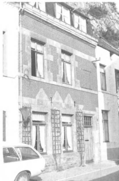
25. Une fenêtre à linteau droit sur montants à queues de pierre dans la façade arrière permet de situer la maison dans le 2<sup>e</sup> quart du XVIII<sup>e</sup> siècle. Dans la façade avant, les ouvertures du rez-de-chaussée datent d'après la guerre 1914-1918 et les fenêtres de l'étage sont peut-être d'origine, mais le cimentage ne permet pas d'en décider. La toiture mansardée que borde une frise ancienne a été réalisée en même temps que le remaniement du rez-de-chaussée (fig. 56).
