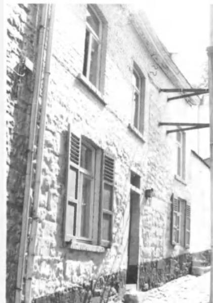
12. Jusqu'alors, c'était une petite construction du XVIII<sup>e</sup> en moellons, large d'une travée de deux niveaux s'ouvrant par une porte à linteau droit sur montants chaînés dont subsiste la trace. Elle était prolongée à gauche par un mur fermant une courette dont la porte sert de base à celle d'aujourd'hui. En 1849, le mur est récupéré pour agrandir l'habitation. Un étage en briques est bâti au-dessus vers 1900. Les annexes à l'arrière datent de 1938.
