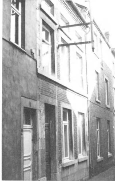
5. Difficile à dater vu l'épais crépi rouge qui couvre la façade, la maison est éclairée par des fenêtres du XIX<sup>e</sup> siècle, qui ont conservé leur châssis d'origine au rez-de-chaussée. Le pignon gauche en moellons se termine par une pointe en pan de bois enduit.
