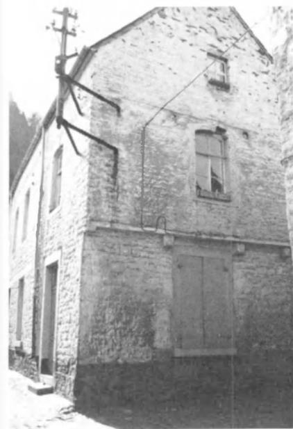
5. La maison constitue une extension du 3, réalisée à la fin du XVIII<sup>e</sup> siècle. Les ouvertures du rez-de-chaussée en moellons calcaires datent du XIX<sup>e</sup> siècle, le linteau de la fenêtre a alors été inséré dans le cordon original, supprimé au-dessus de la porte. L'étage est en briques à partir des seuils des fenêtres à linteau droit et clé, repris dans un cordon continu, sur montants à queues de pierre. Relié par un chaînage, le pignon est en-
