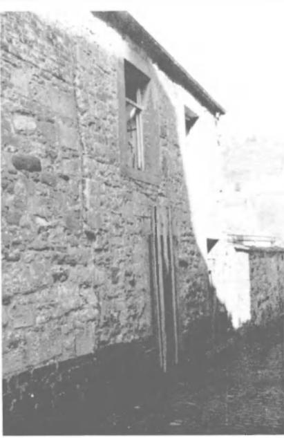
**2-4.** Détaché en 1849 du 76 rue Fétis, le volume peint en moellons calcaires sur soubassement cimenté, remonte au XVIII<sup>e</sup> siècle comme le montre à l'étage la fenêtre obturée à linteau droit sur montants à queues de pierre. Les autres ouvertures sont des XIX<sup>e</sup> et XX<sup>e</sup> siècles, car la maison a été à un moment donné divisée en deux habitations.
