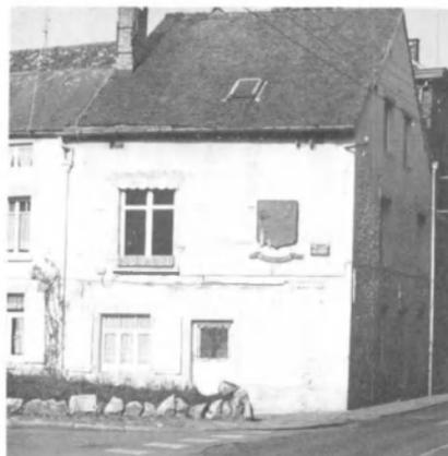
pan de bois avec remplissage de moellons à l'étage, sont plus récentes. La toiture d'ardoises a conservé des cavaliers en poterie ancienne.
