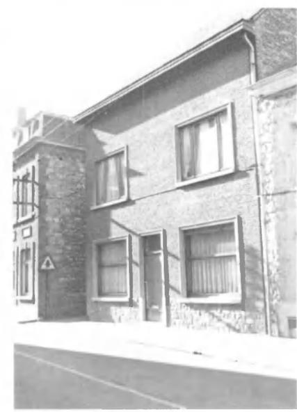
nêtre percée au XIX<sup>e</sup> siècle, est surmonté d'un étage et d'un pignon en briques éclairé d'une baie d'origine sur montants à queues de pierre. Des épis longent la bâtière. Dans le prolongement, le niveau de moellons 1, place du Bailliage qui garde la trace d'une porte chaînée, a été nouvellement exhausé en briques.
