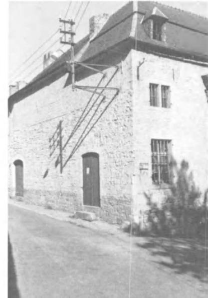
moulurées, s'ouvrant vers la cour. Une corniche de pierre en cavet court sur l'ensemble, opérant un décrochement là où la bâtière d'ardoises se transforme en Mansard interrompu par des lucarnes à penne.
