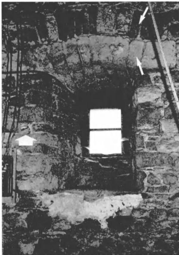
Fig. 25. Warsage; niveau +1; fenêtre sud; vue de l'intérieur. A noter : le double arc de décharge. La courte et grosse flèche, à gauche, indique le boulin où le bois fut prélevé en vue du C14.
