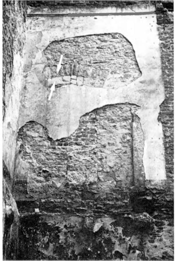
Fig. 16. Fontaine; étage seigneurial; fenêtre à banquette ouest et à double décharge.
