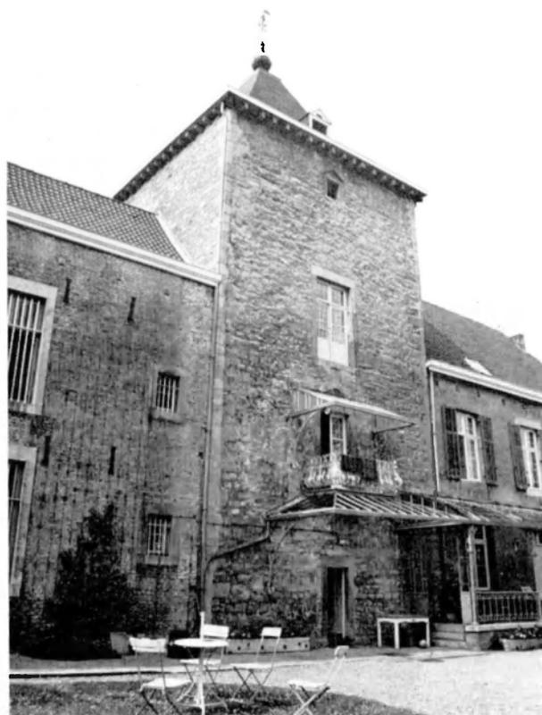
b) La *face nord-ouest* (fig. 18) regarde la cour intérieure d'une importante exploitation agricole à dépendances multiples et d'âge différent. A cette face, on distingue quatre niveaux. L'entrée actuelle, de plain-pied, a la même signification que celle de la face sud-est. La grande fenêtre rectangulaire du niveau +1 a pris la place d'un soupirail ancien en fente. La baie de l'*étage résidentiel* est désaxée, mais toujours présente. Au *niveau +3* la face nord-ouest est aveugle.
