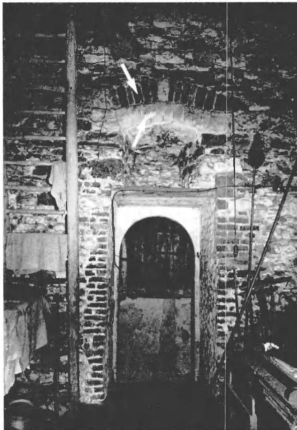
Fig. 26. Warsage; niveau +1; restes de la fenêtre nord; vue de l'intérieur. A noter : le double arc de décharge. Accès actuel de la tour.
