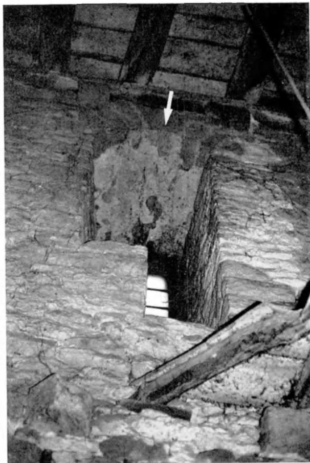
Fig. 30. Warsage; niveau +2; vue intérieure de la face nord; fenêtre à banquette et à décharge unique.
