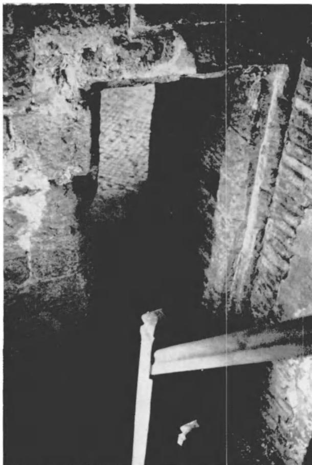
Fig. 39. Fernelmont. Entrée de l'habitation au premier étage et feuillure de la passerelle amovible.
