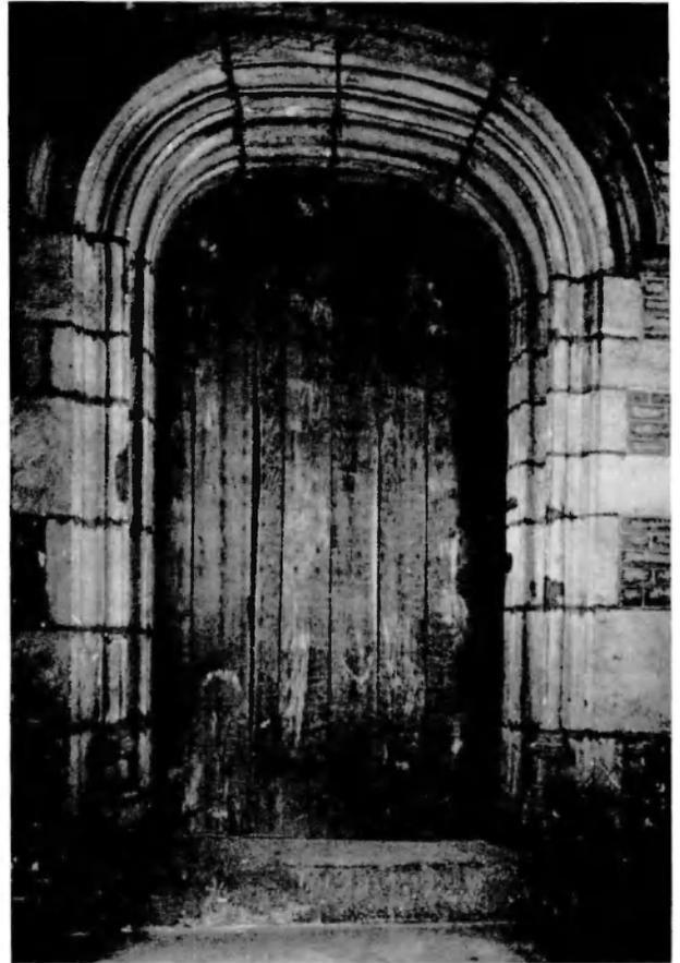
Fig. 19. Porte du grenier à piédroits moulures. (Photo ACL.)
