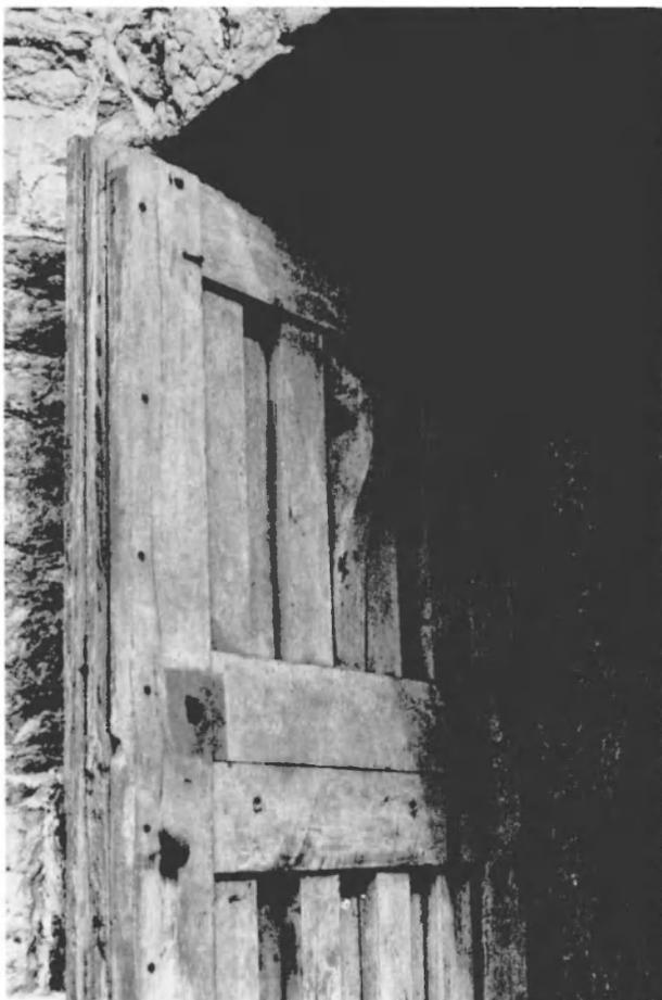
Fig. 38. Fernelmont. Détail du vantail extérieur. Poulie en relation avec l'ancien pont mobile.
