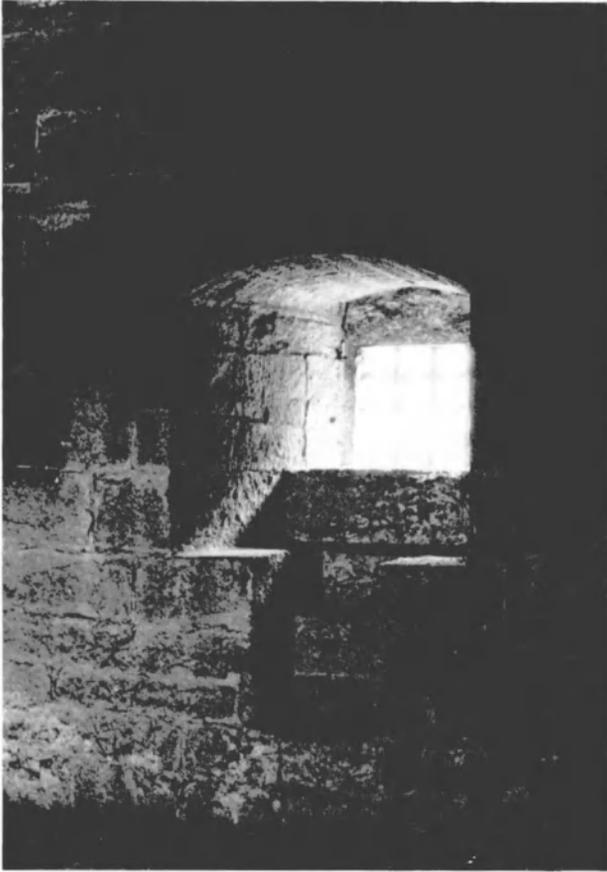
Fig. 46. Fernelmont. Fenêtre à banquettes du premier étage, face est.
