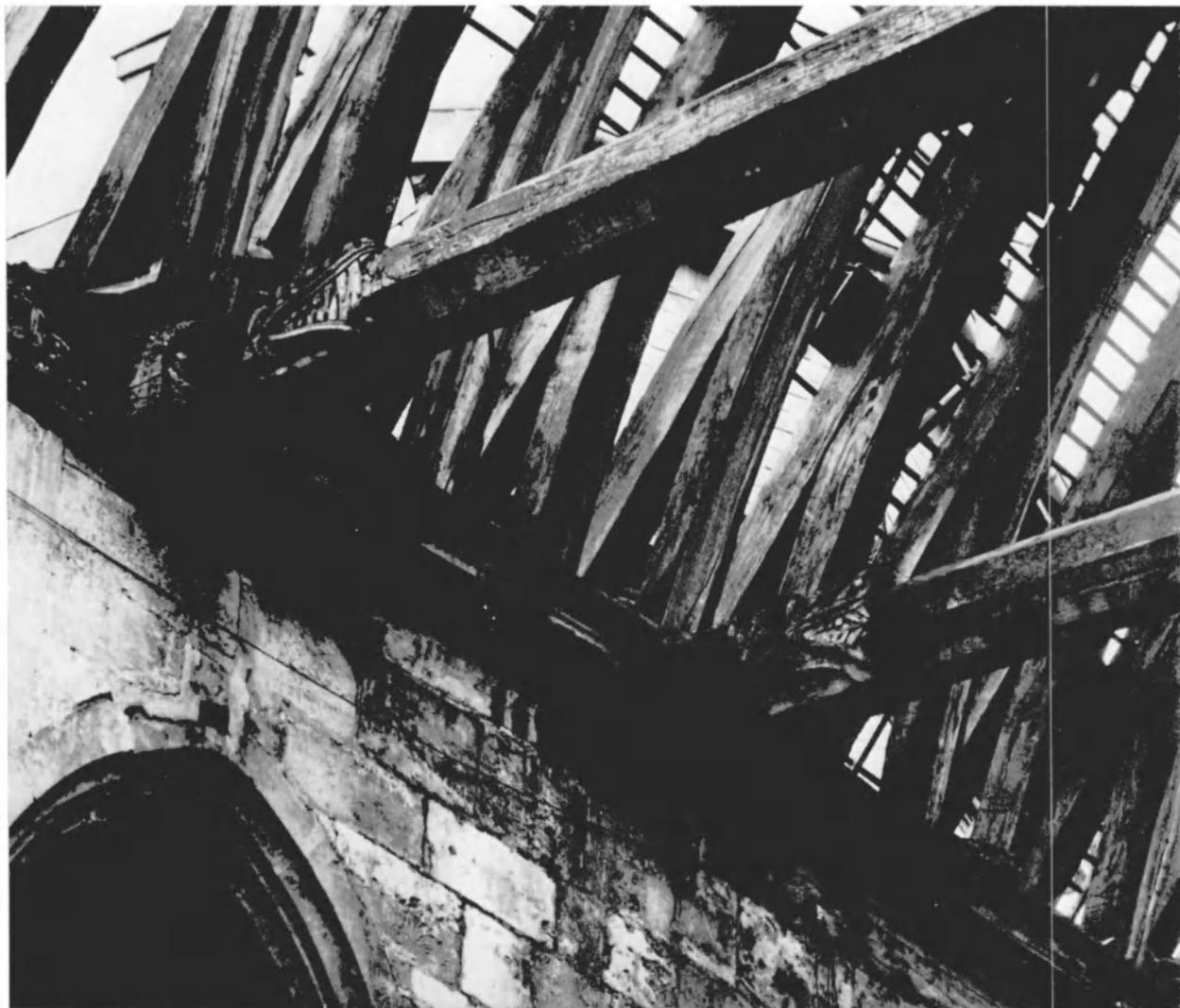
Fig. 28. Charpentes de l'église paroissiale de DOUDEAUVILLE (Eure), seconde moitié du XVI<sup>e</sup> s. Types d'engoulants différents dans la nef et le chœur.
