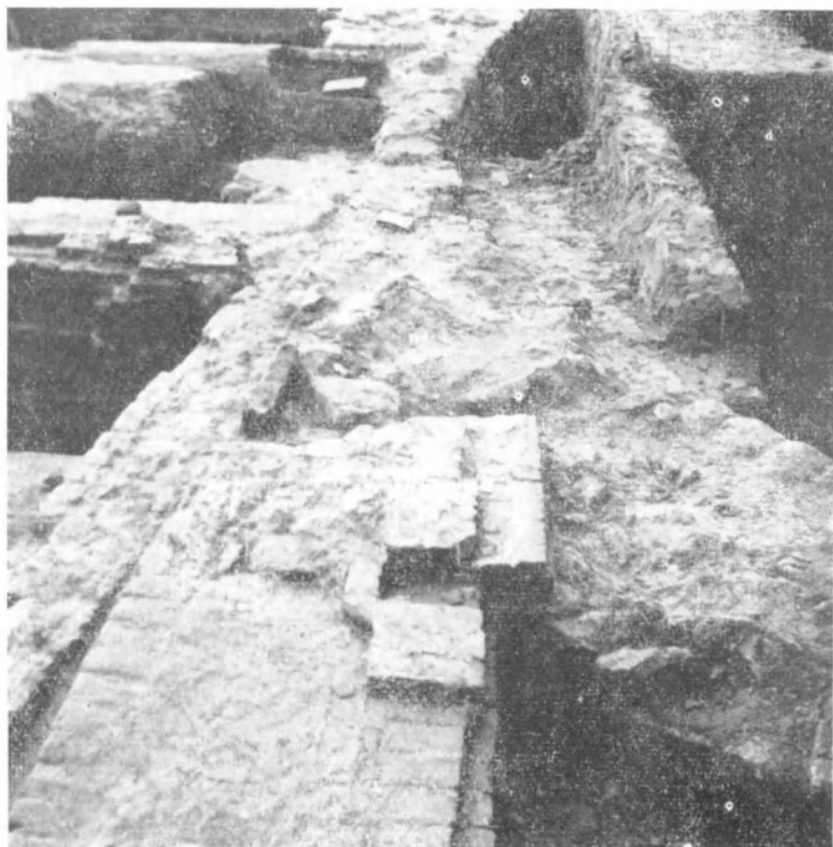
Afb. 36. — Oostelijke afsluiting van de karolingische kerk met aanzetten van gothisch gebouw.
