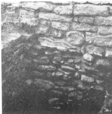
Afb. 29. — Fundering van toren en traptoren (X e eeuw).
