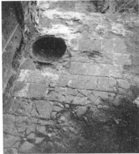
Afb. 31. — Oude bevoering in de toren, met kom in de vloer gemetseld.
