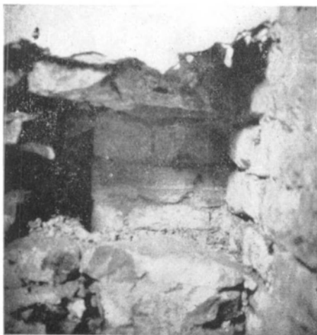
Afb. 45. — Opstaande rib van het graatgewelf in de toren.
