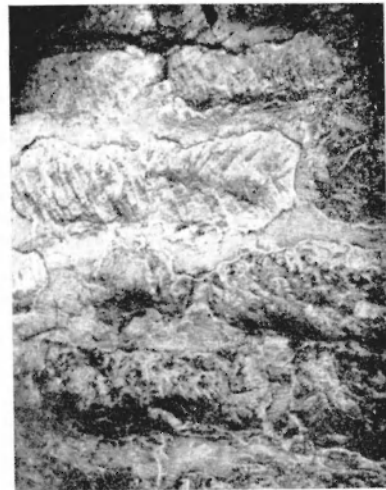
Afb. 52. — Steenbekapping in de toren (X e eeuw).
