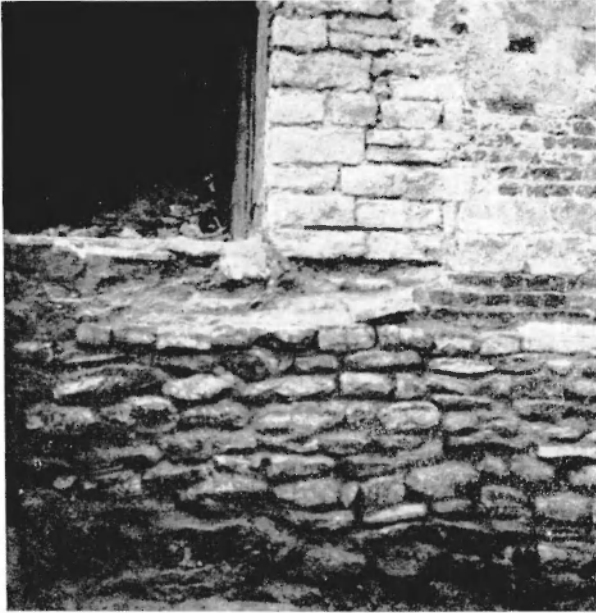
Afb. 51. — Oostelijke fundering van de toren, met ingang tot de kerk.
