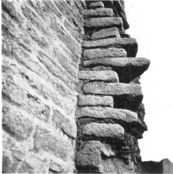
Afb. 58. — Aanzet van de polygonale karolingische muur op de zuidflank van de toren.
