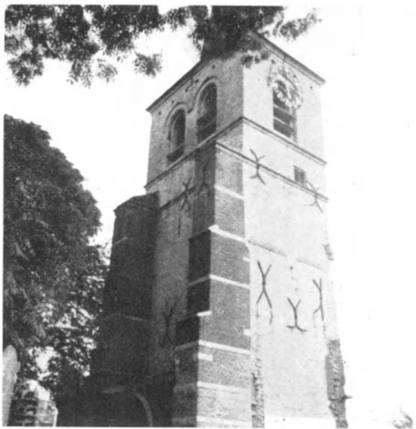
Afb. 15. — De toren van uit het Z.-W., met moderne steunberen (1865).
