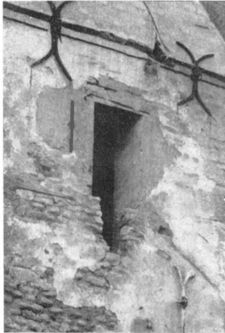
Afb. 48. — Overblijfsel van primitief venster (X e e.) in de oostflank van de toren.
