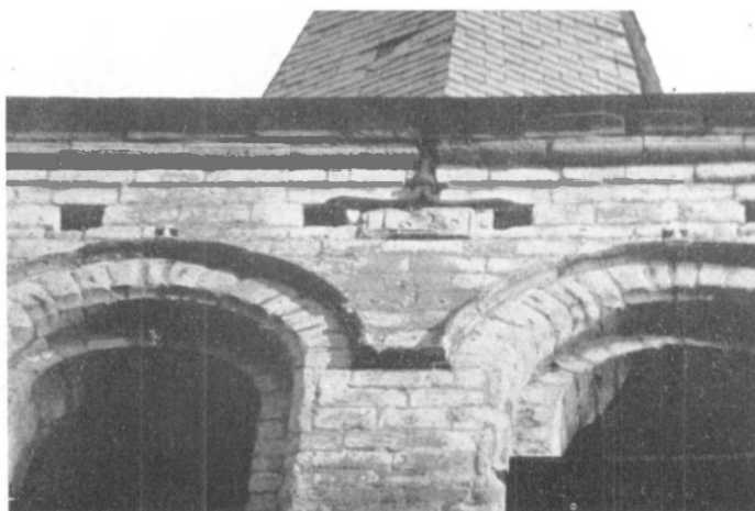
Afb. 24. — Gedeelte van de bovenverdieping van de toren (1625). (Foto: E. P. Van Ruyseveldt.)
