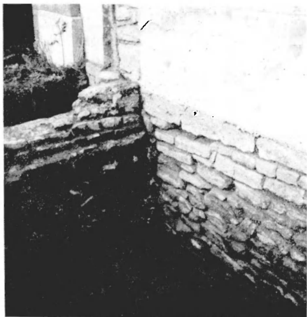
Afb. 20. — Zuidelijke fundering van de toren.
