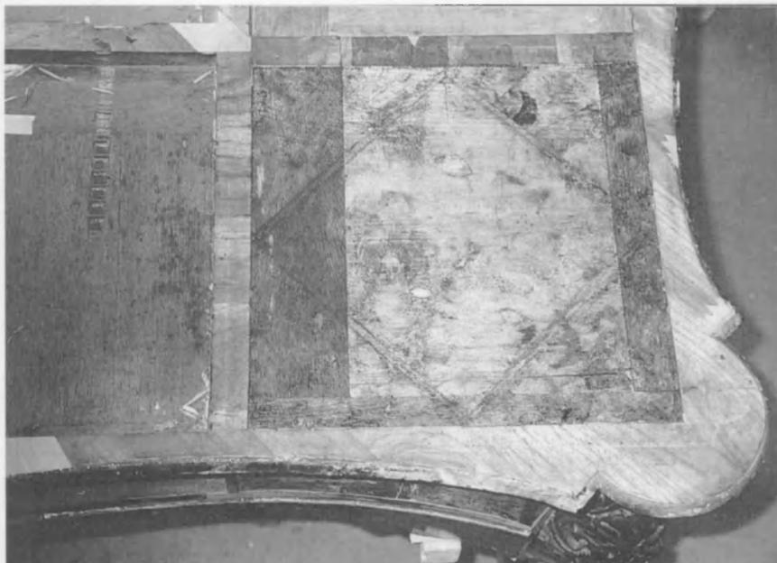
Fig. 6. Le bâti sous la marqueterie fraîchement déposée, à l'avant-gauche. On distingue la colle et le panneau de sapin fendu.
