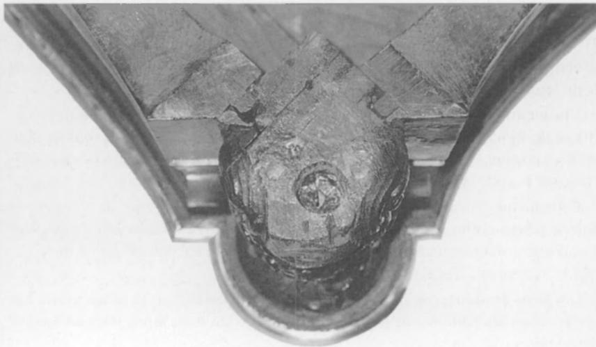
Fig. 1. Montage du pied avant-droit avant recollage
